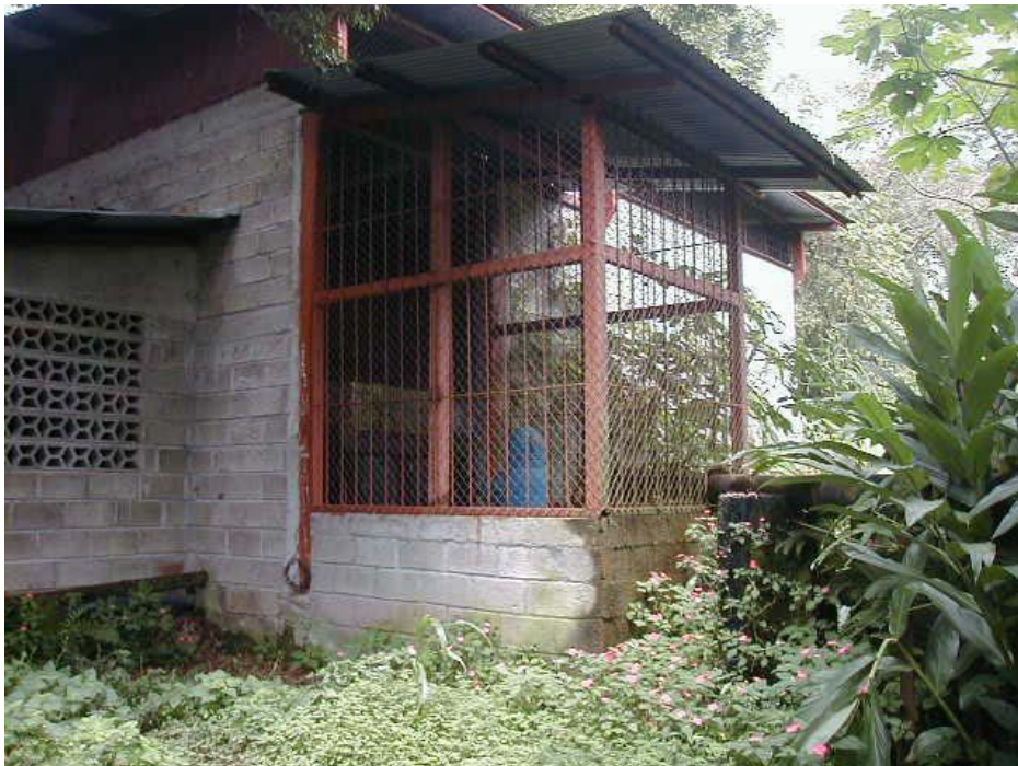
Estación de Bombeo Amelia
